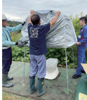
仮設トイレを設置した
