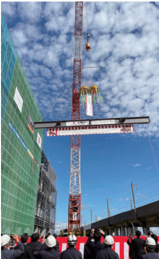
関係者が見守る中、上棟梁を引き上げた
